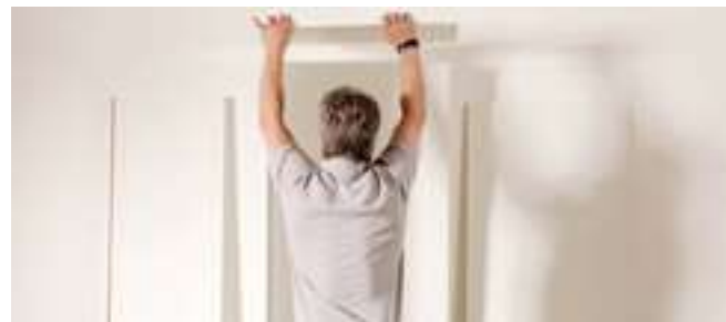
Colocar la tapa y desplazarla hacia el lateral del mueble.
