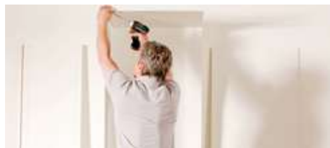
Tener preparado el atornillador a batería y atornillar la esquina delantera. De este modo, los montajes realizados por una única persona son posibles sin problemas.
