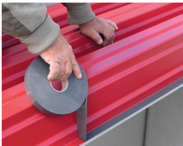
Ejemplo de instalación: ISO-ZELL FIXTAPE
