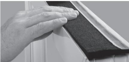
5. El tamaño de la cinta está determinado por la anchura del marco individual de la ventana. La reserva de expansión y adición en la formación de esquinas debe ser considerada según la anchura de la junta.
